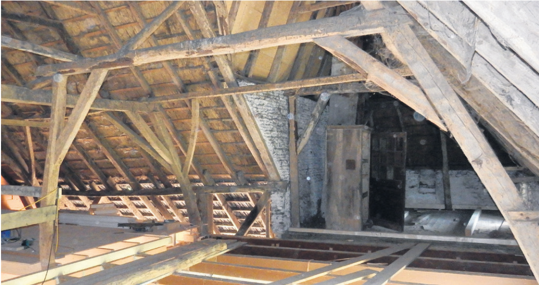
De WarmBouwen-techniek bleek de oplossing te zijn bij de renovatie van de monumentale boerderij.
